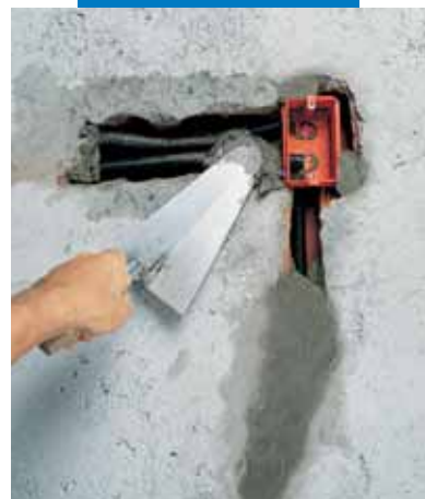
Fissaggio di scatole e tubazioni elettriche con Lampocem
