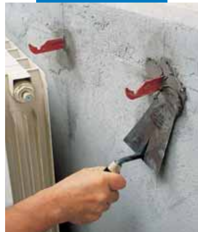
Posa di zanche per caloriferi con Lampocem
