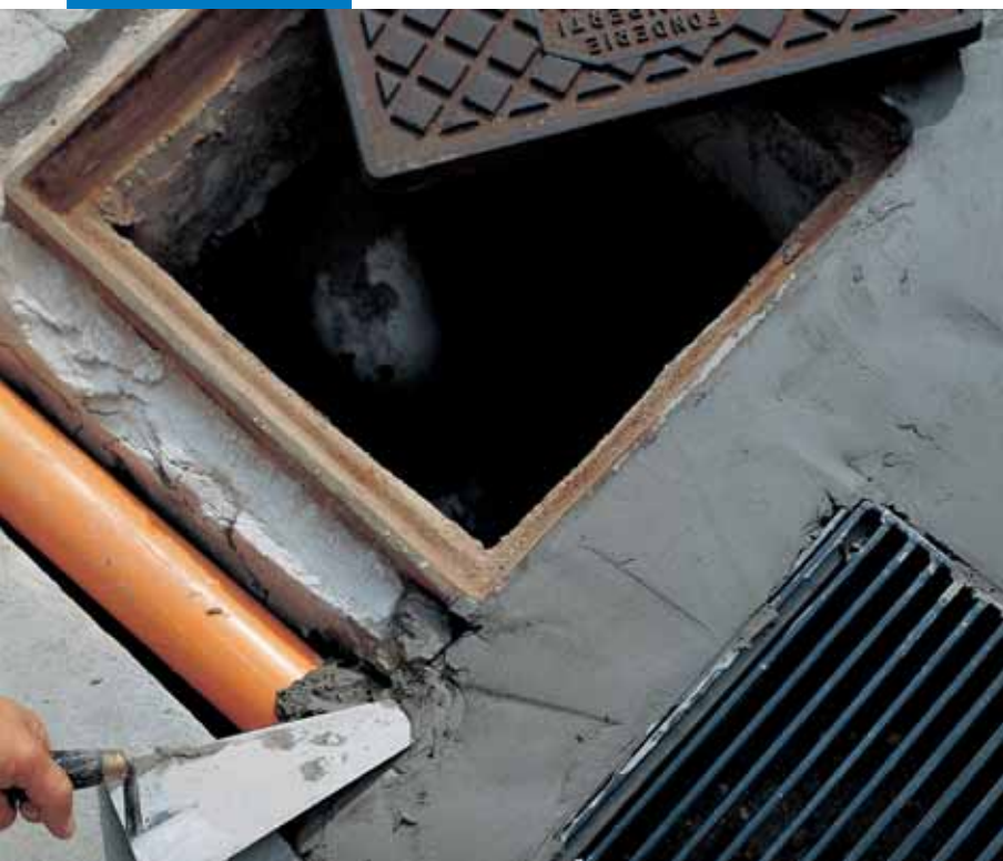
Posa di tubazioni e chiusini stradali con Lampocem
