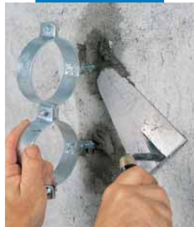
Fissaggio di collari per tubazioni con Lampocem
