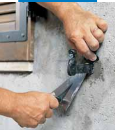
Posa di zanche per finestre con Lampocem
