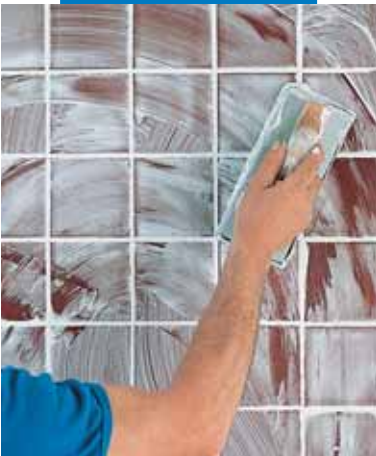
Stesura con spatola gommata
