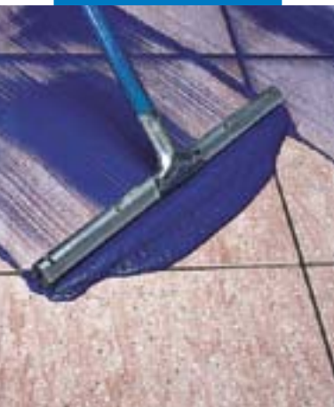
Stuccatura di pavimento in porcellanato con racla
