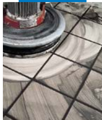
Finitura a pavimento con macchina a mono-disco rotante
