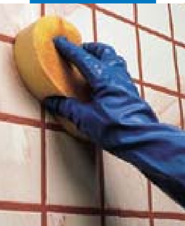
Finitura a parete con spugna (fughe ancora fresche)
