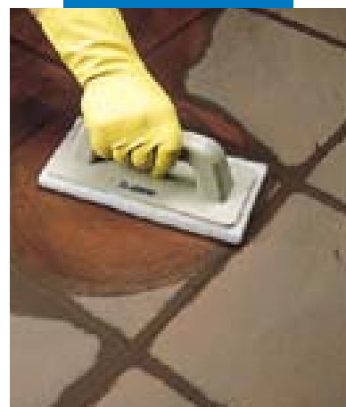
Finitura a pavimento in cotto con Scotch-Brite®
