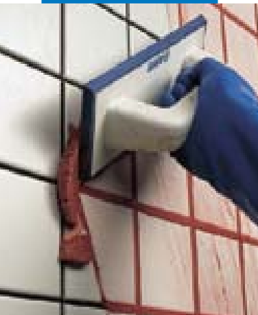
Stuccatura a parete con spatola di gomma
