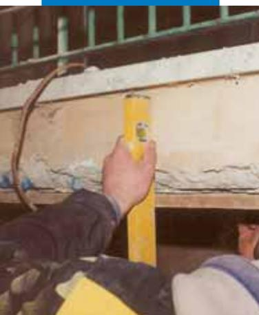
Ripristino di frontalini di balconi: posizionamento di sponda di contenimento
