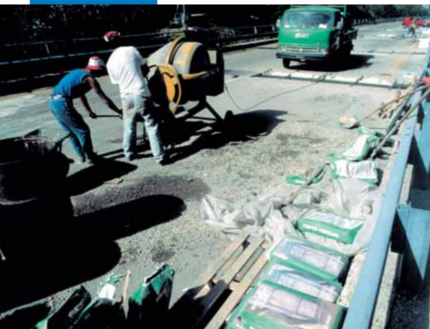
Rifacimento di giunti stradali
