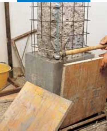
Disarmo da cassero in legno
