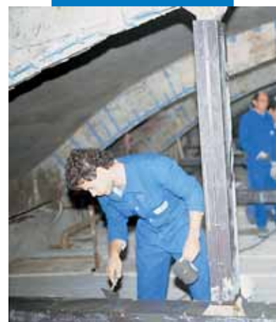
Getto con Mapegrout Colabile in cassero metallico
