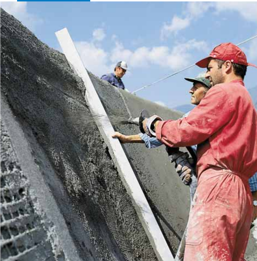
Applicazione di Mapegrout T40 con macchina intonacatrice
