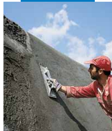
Rifinitura del Mapegrout T40 a frattazzo
