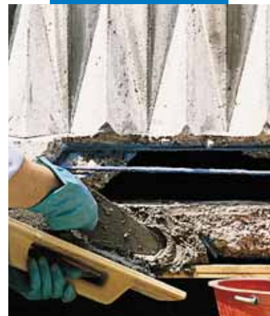
Esempio di riparazione di un balcone con Mapegrout T40 "fase iniziale"
