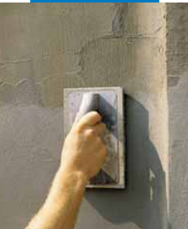
Lisciatura con frattazzo di spugna
