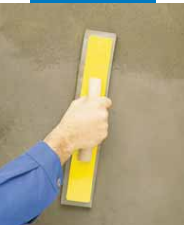
Lisciatura con frattazzino di spugna
