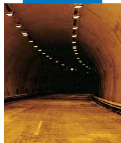
Applicazione a spruzzo di Idrosilex Pronto bianco in galleria autostradale
