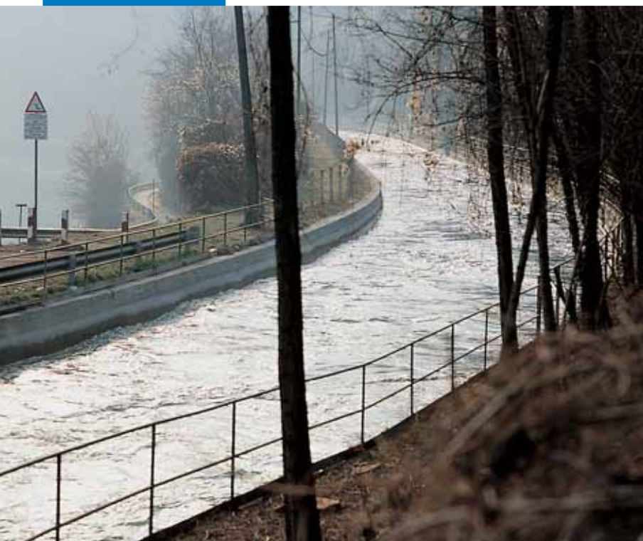
Canale idroelettrico Bertini - Robbiate (CO) trattato superficialmente con Idrosilex Pronto
