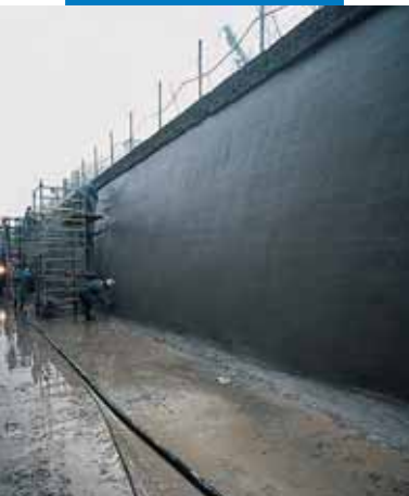
Canale idroelettrico Bertini - Robbiate (CO): vista d'insieme
