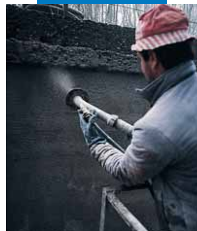
Canale idroelettrico Bertini - Robbiate (CO): applicazione a spruzzo
