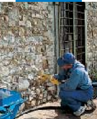
Iniezione di consolidamento con Mape-Antique I
