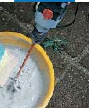
Preparazione della boiaccia di Mape-Antique I
