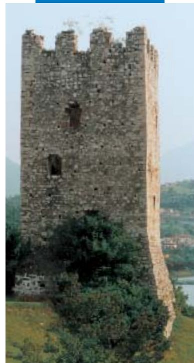
Torre di S. Floriano consolidata mediante iniezione di Mape-Antique I
