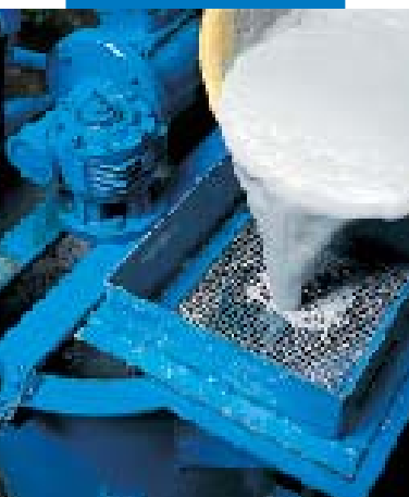
Riempimento della pompa di iniezione con Mape-Antique I
