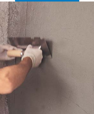
Applicazione di Planitop 540 con spatola metallica
