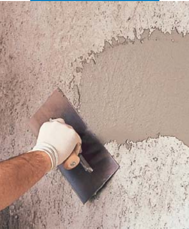
Applicazione di Planitop 540 con spatola metallica
