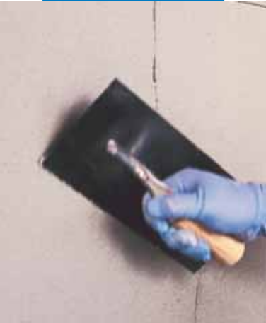
Applicazione di Planitop 560 con spatola metallica
