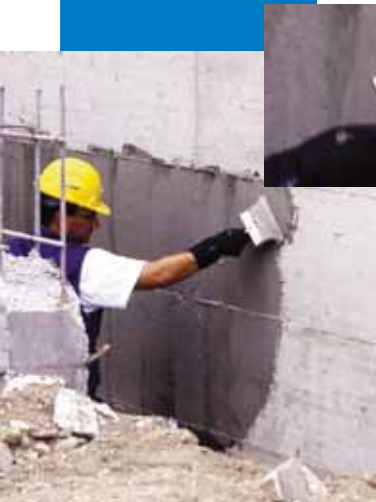
Impermeabilizzazione di muro di fondazione a pennello
