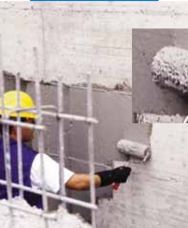
Impermeabilizzazione di muro di fondazione a rullo
