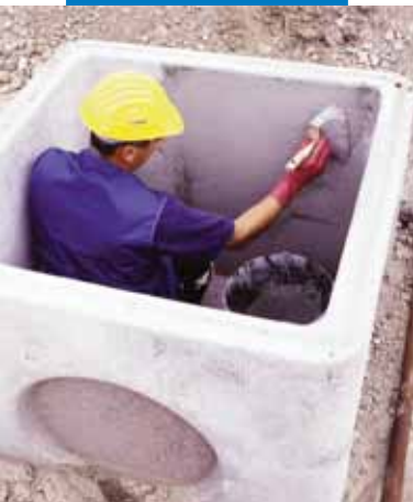
Impermeabilizzazione di pozzetto in cemento a pennello
