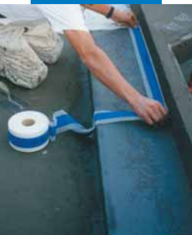
Esempio di impermeabilizzazione di Mapeband dell'angolo tra fondo e parte di una vasca
