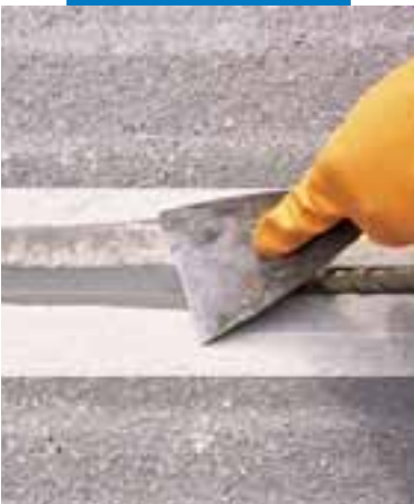
Livellamento del giunto mediante eliminazione del sigillante in eccesso
