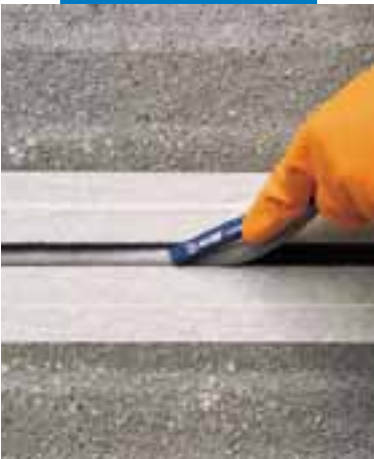
Applicazione del nastro protettivo e introduzione di Mapefoam nel giunto
