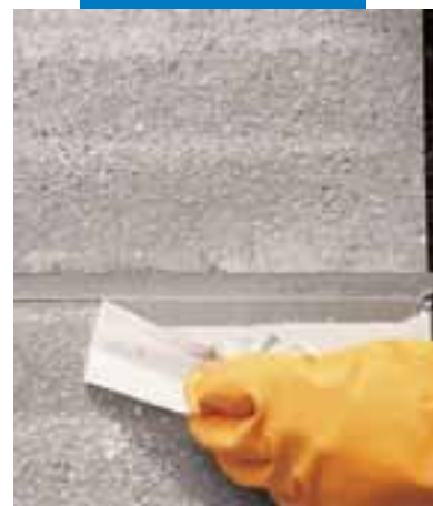
Rimozione del nastro adesivo protettivo
