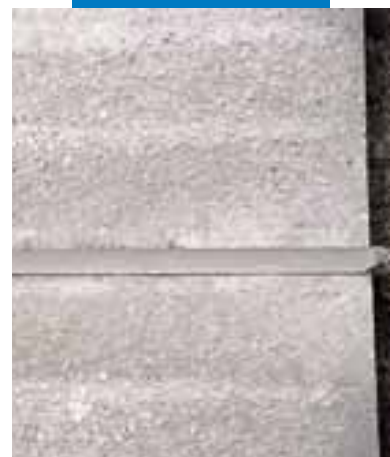
Vista finale del giunto dopo la rimozione del nastro protettivo
