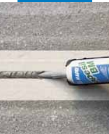
Riempimento del giunto con Mapesil BM
