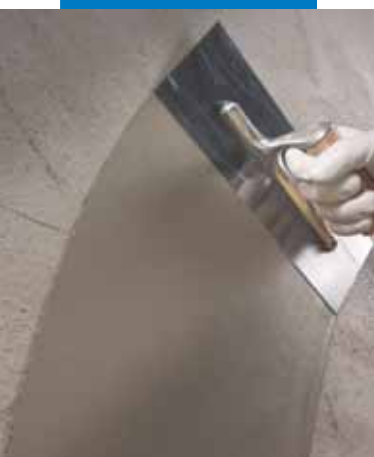
Applicazione di Planitop 200 su calcestruzzo
