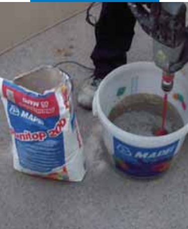
Preparazione di Planitop 200
