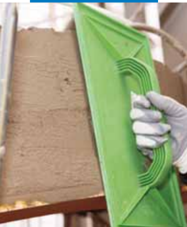
Frattazzatura di Planitop 430
