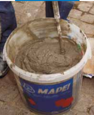
Preparazione di Planitop 430
