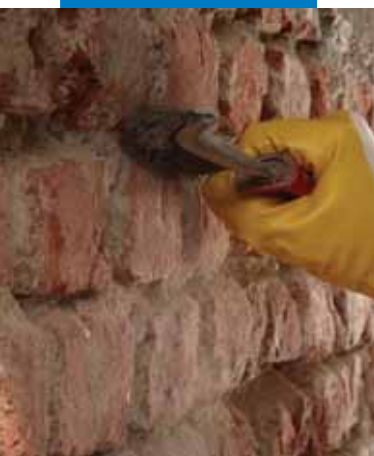
Preparazione del supporto
