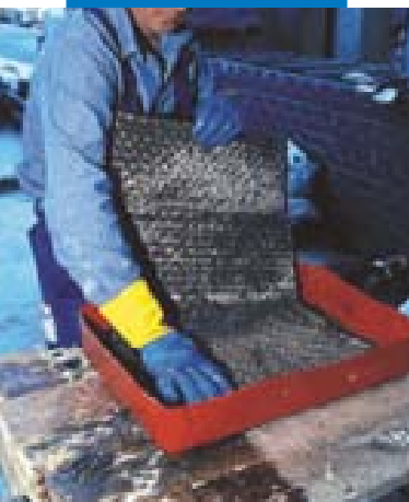
Impregnazione manuale di Mapewrap C
