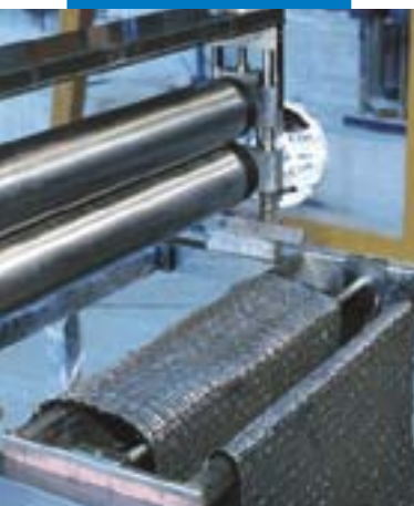
Impregnazione a macchina di Mapewrap C
