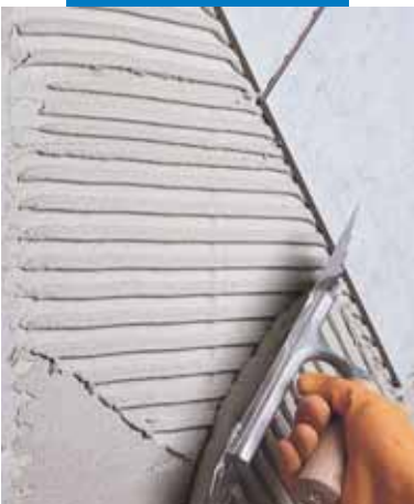
Posa di monocottura su parete in blocchi di cemento cellulare espanso
