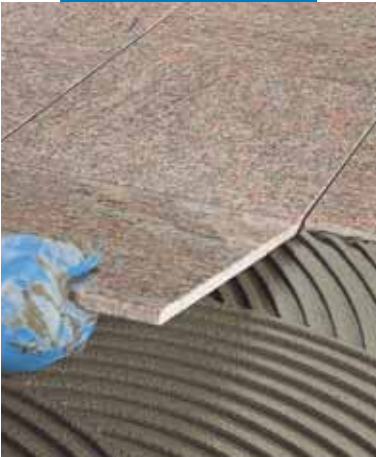
Posa di marmo prelevigato a pavimento
