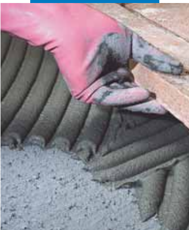
Posa di cotto fatto a mano su massetto sconnesso
