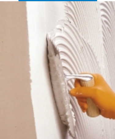
Stesura di Tixobond White su supporto
