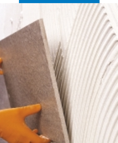
Posa di piastrella in bicottura di grande formato a parete dall'alto verso il basso
