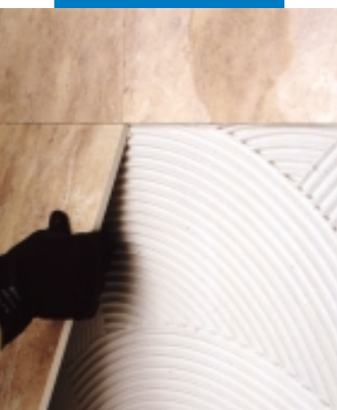
Posa di gres porcellanato di grande formato a parete
