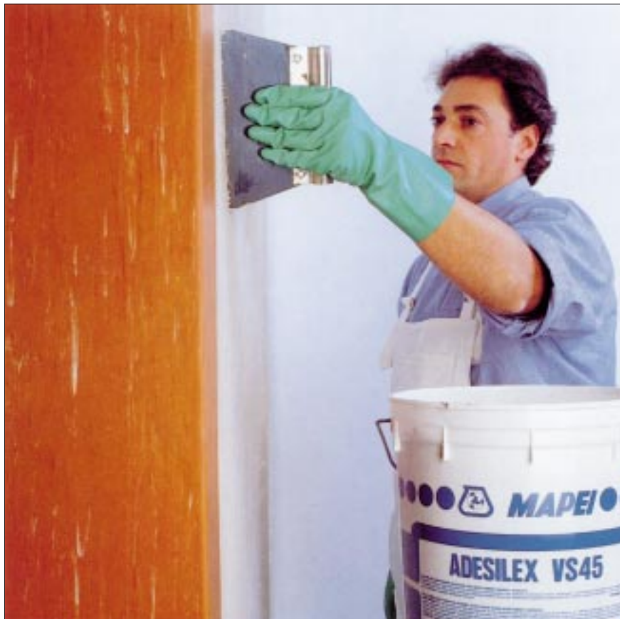
Stesura dell'adesivo dopo la posa del telo in PVC risvoltato sullo spigolo
