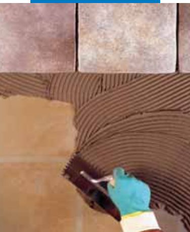
Posa di gres porcellanato in ambiente commerciale (Concessionaria My Way - Drogenbos - Belgio)
