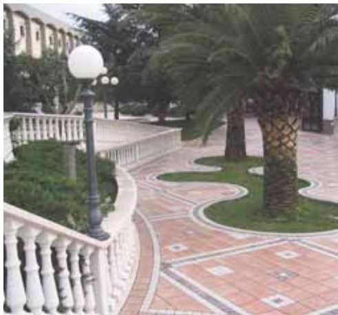
Posa di gres porcellanato a pavimento in esterno (Centro Convegni Matera - Italia)
