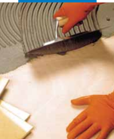
Posa di grès porcellanato con Elastorapid su supporto in multistrato marino
