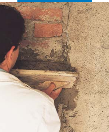
Restauro di vecchia muratura
