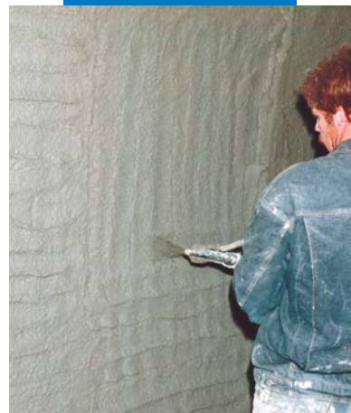
Applicazione di Nivoplan a spruzzo
