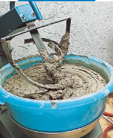
Impasto con minibetoniera
