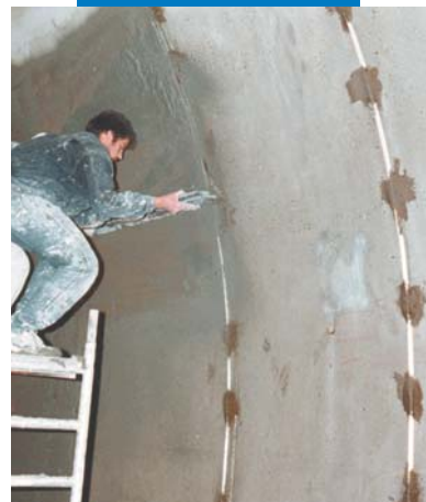
Staggatura dell'intonaco
