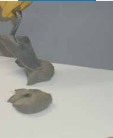
Applicazione di Mapetherm AR1 sul rovescio del pannello a punti con cazzuola
