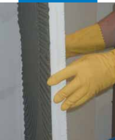
Posa di pannelli termoisolanti
