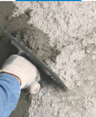
Applicazione del primo strato di Planitop HDM
