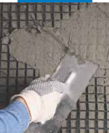
Posizionamento di Mapegrid G 220
