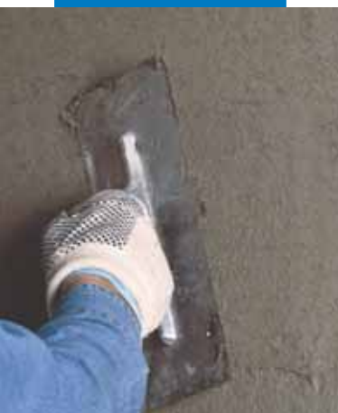
Copertura di Mapegrid G 220 con ulteriore mano di Planitop HDM
