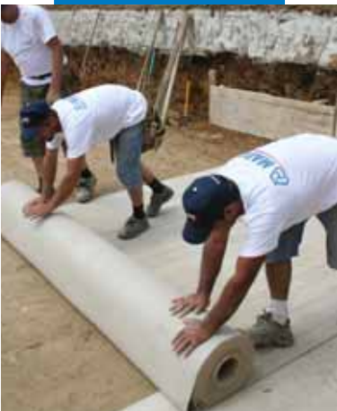
Esempio di posa di Mapeproof su superficie orizzontale
