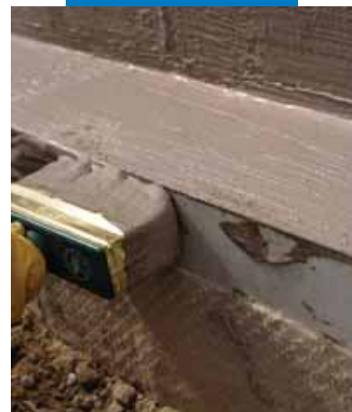
Impermeabilizzazione delle pareti verticali con Mapeproof e Mapelastic Smart
