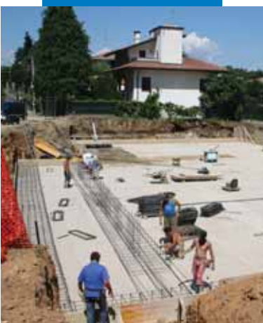
Impermeabilizzazione fondazioni villetta
