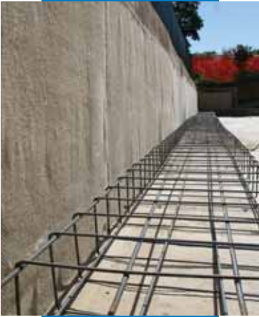
Posa di Mapeproof su diaframma
