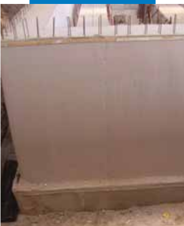
Impermeabilizzazione di superfici verticali in post getto
