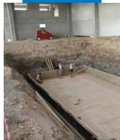
Impermeabilizzazione orizzontale con Mapeproof
