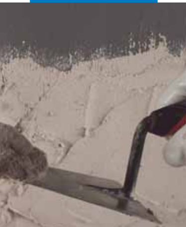
Applicazione di intonaco su Eco Prim Grip
