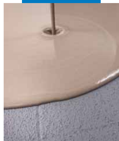
Applicazione di rasatura autolivellante Ultraplan su Eco Prim Grip asciutto ed applicato su vecchio pavimento
