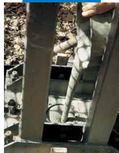
Inghisaggio con Mapefill
