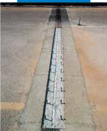
Ripristino di giunto di ponte autostradale con Mapecfill
