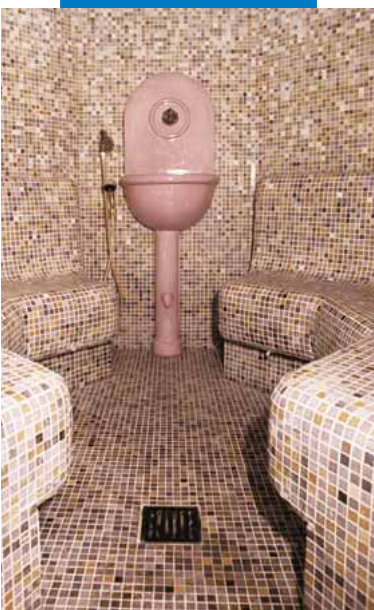
Esempio di posa di mosaico vetroso in un bagno turco - Park Hotel Gritti - Bardolino (VR)
