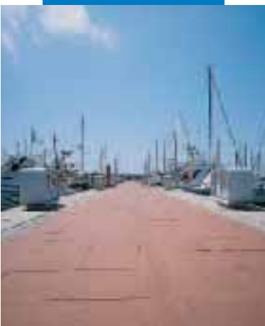
Nuovo porto di Civitavecchia: posa di cotto in esterno con Keracrete
