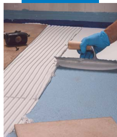
Incollaggio delle piastrelle su Mapelastic® AquaDefense
