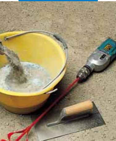
Impasto di Mapelastic con agitatore meccanico
