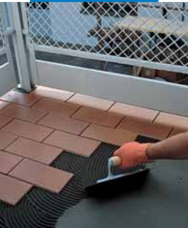
Posa di piastrelle con Granirapid su un balcone impermeabilizzato con Mapelastic
