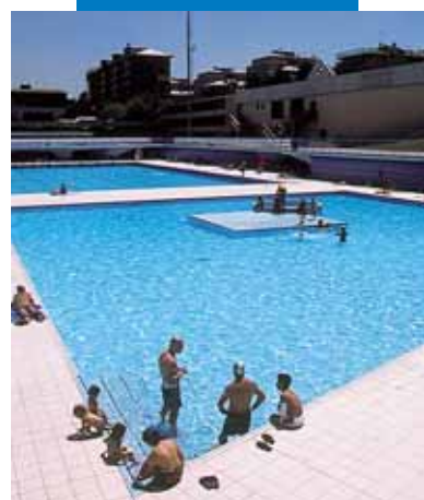
Piscina impermeabilizzata con Mapelastick - Piscina Scarioni - Milano - Italia
